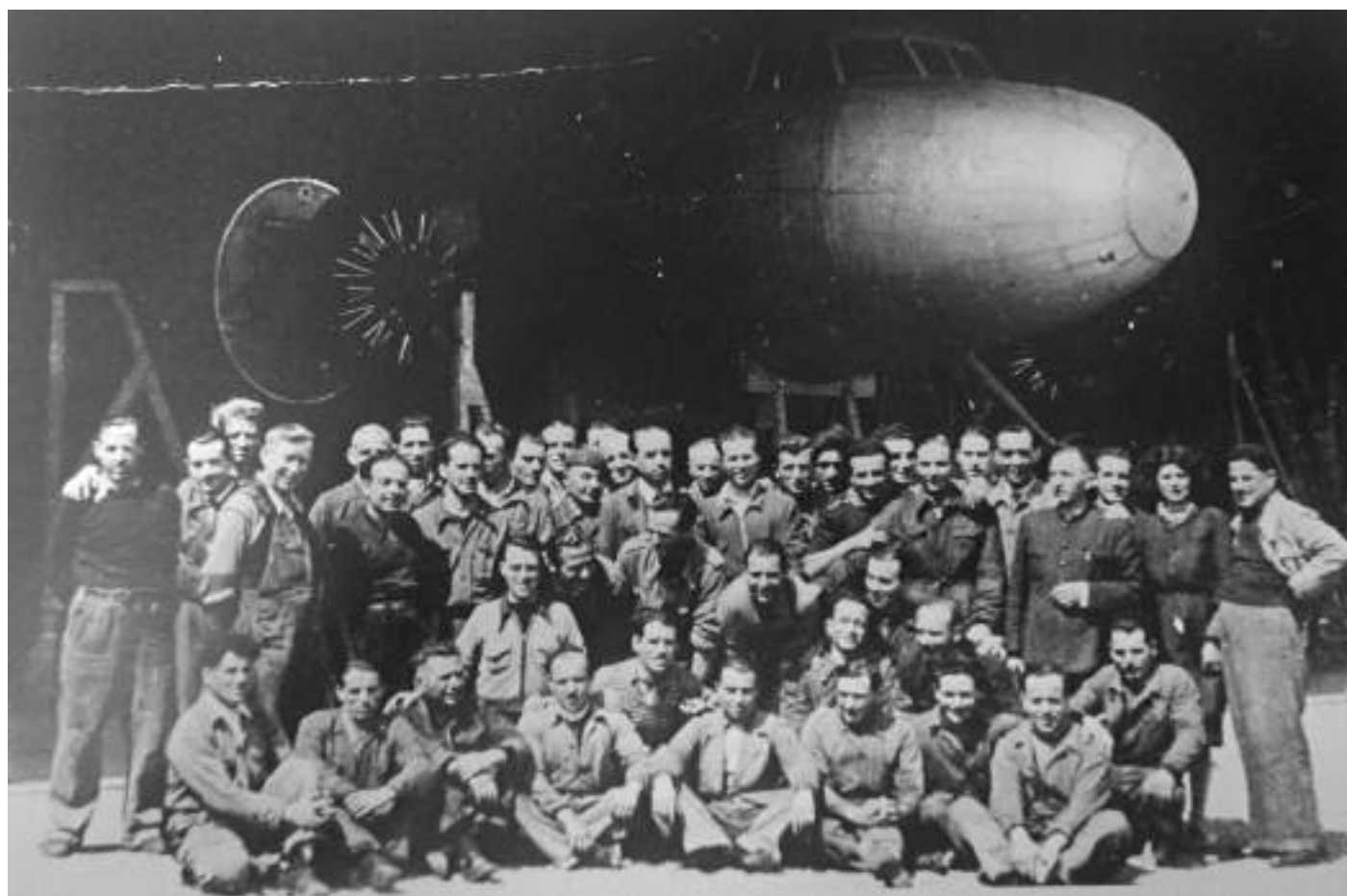
Lavoratori dell'industria in Valle Bormida
